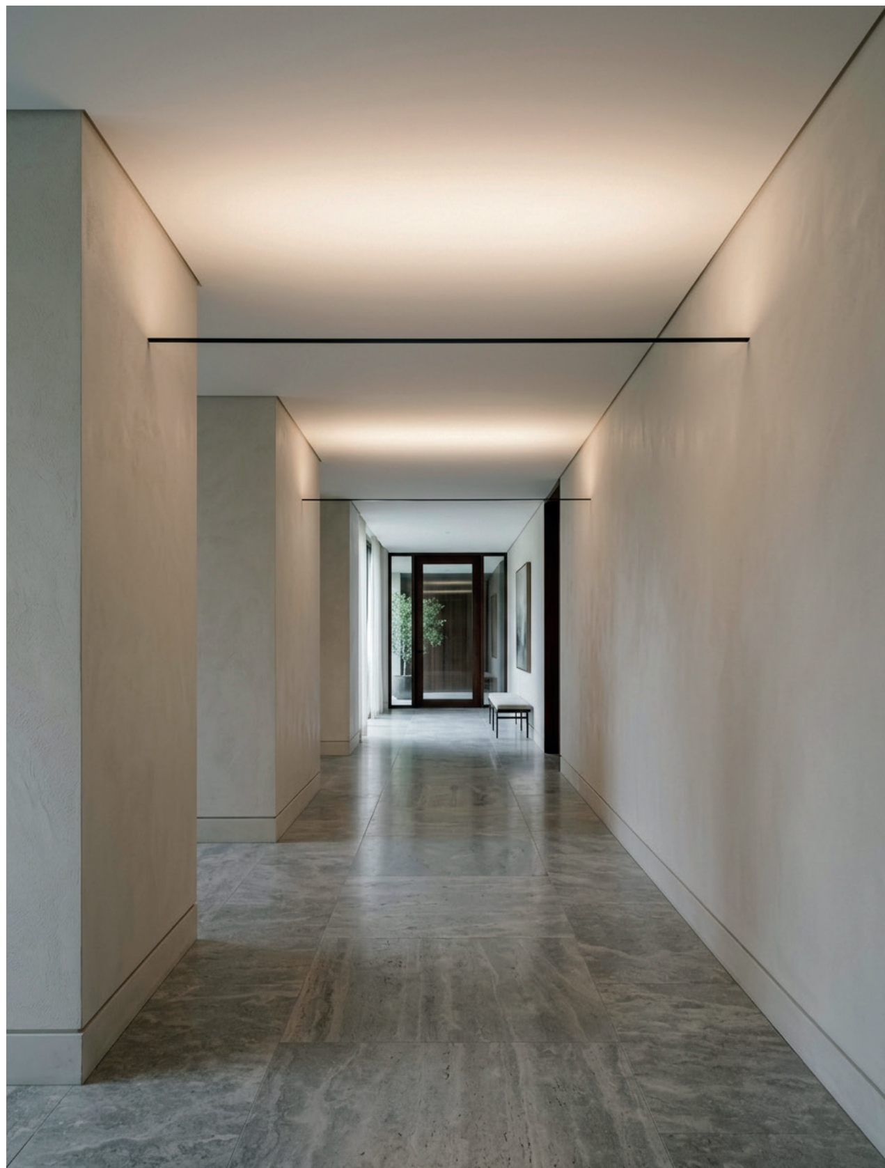
Illuminazione lineare – sistema di luce continua sospeso tra due punti Linear lighting – continuous light system suspended between two points
